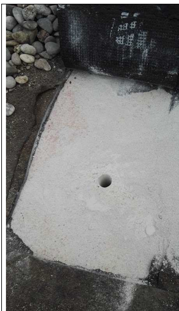
Foro di ispezione spessore solaio copertura (circa 18cm)
